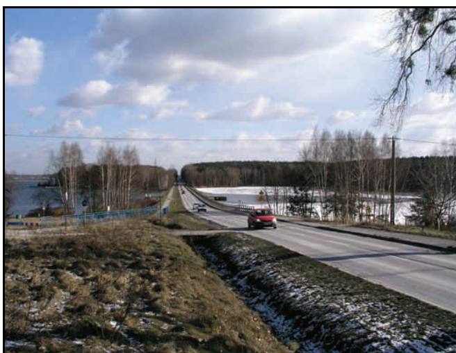
Fot. 2. Wolny od pokrywy lodowej główny akwen Zbiornika Rybnickiego i jego boczny Pniowiec z pokrywą lodową częściowo przykrytą śniegiem (fot. M. Rzętała).
